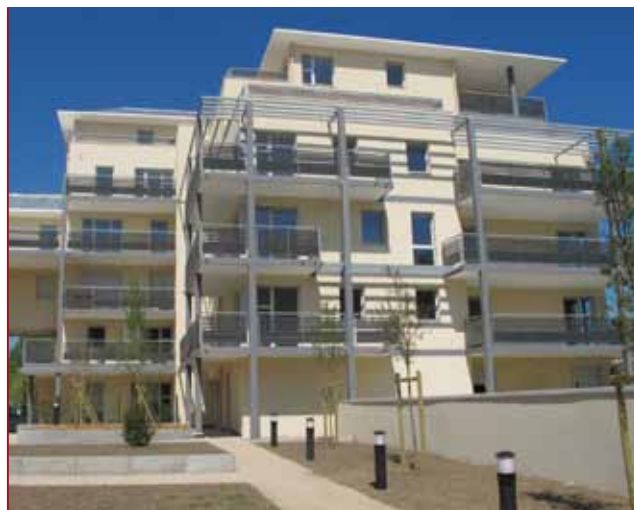
De nouveaux habitants ont été accueillis dans de nouveaux logements sociaux locatifs ou en accession à la propriété : rue Louise Michel, Le Clos des Tulipes et Le Boléro.
