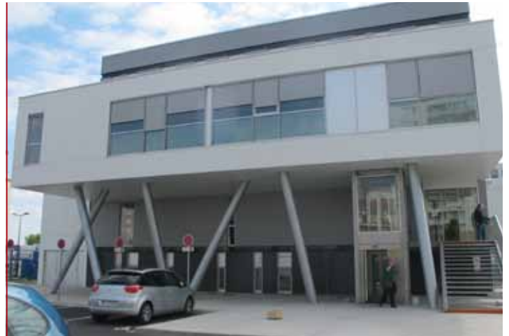
L'Hôpital privé de l'ouest parisien a inauguré son extension et la rénovation de ses locaux en juin.
