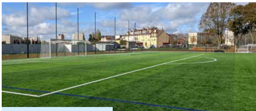
Un premier terrain synthétique déjà en fonction au stade Gravaud
